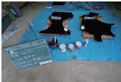
樹洞上部 FRP 補強屋根蓋型取り
