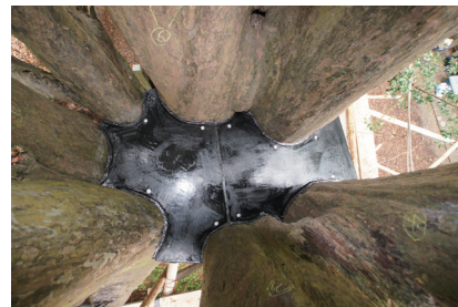
FRP 補強屋根蓋取付け
