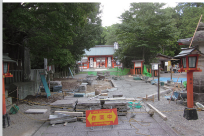
参道石畳根圏迂回設置工事
