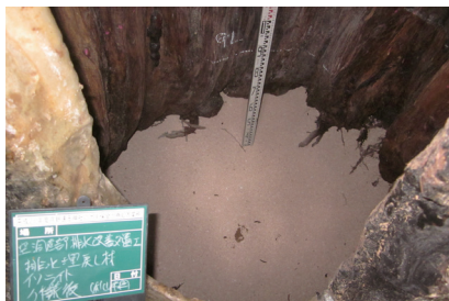
腐植撤去珪藻土焼成資材埋戻
