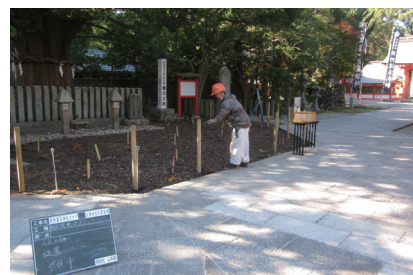
人止めロープ柵設置
