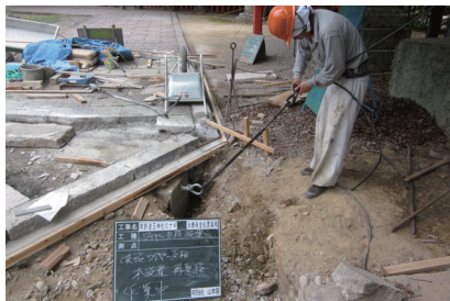
ワイヤー支柱本設置
