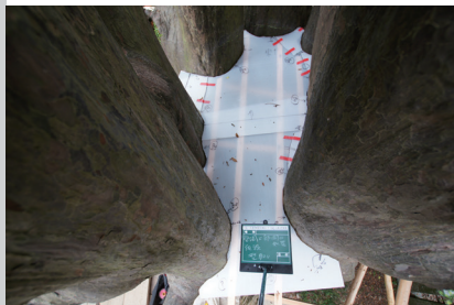
樹洞上部 FRP 補強屋根蓋型取り
