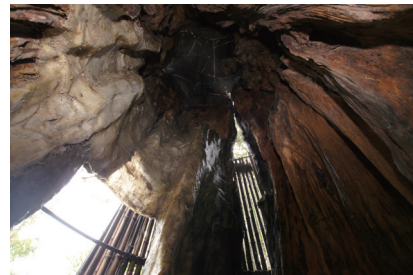
樹洞内壁 FRP 補強施工後
