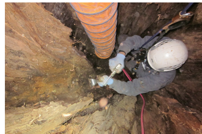
樹洞腐朽残渣除去整形
