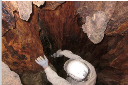
樹洞内壁木質強化剤含浸
