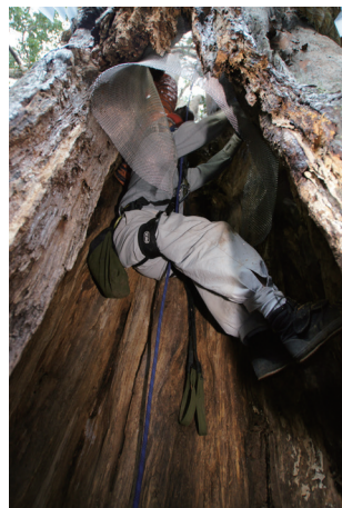
樹洞内壁補強
