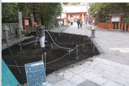
発根促進表層改良工
