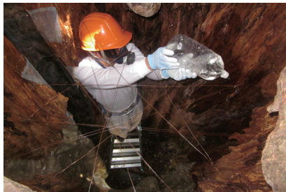
樹洞内壁木質強化剤含浸
